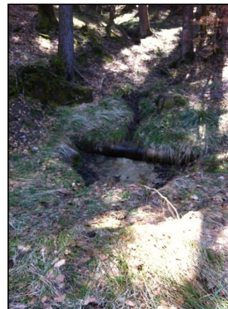
Fig.21: Affluent de la Belle-Cierne, seuil
