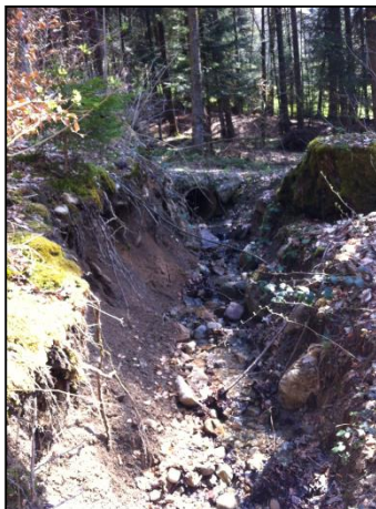
Fig. 30: canalisation affl. 96700, passage aval
