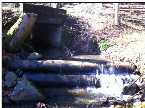
Fig. 13: passage aval, seuil
