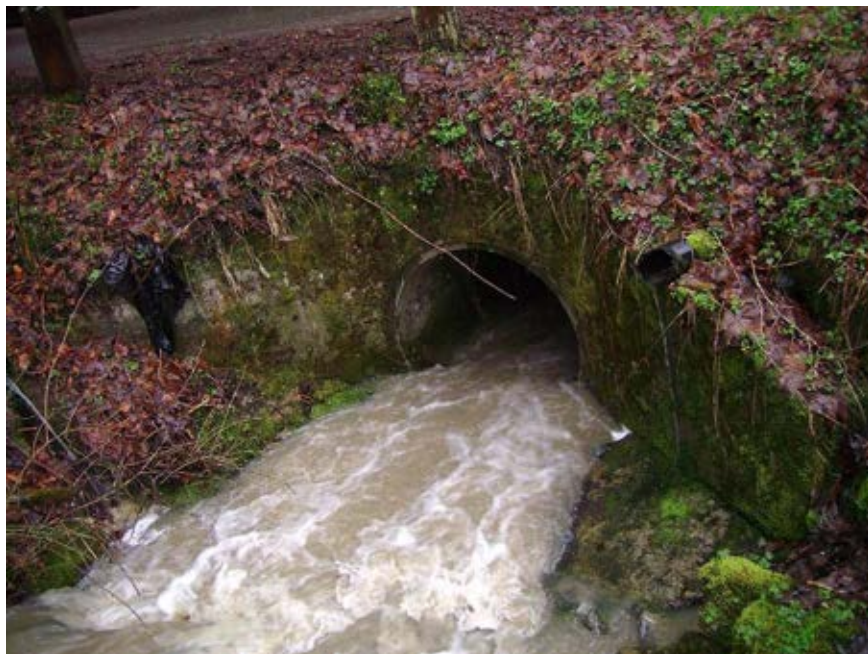
Photo 1 : côté amont du passage
