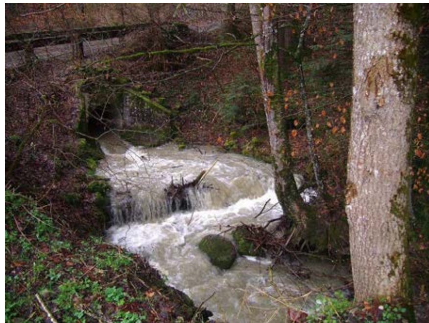
Photo 2 : côté aval du passage
