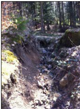
Fig. 30: canalisation affl. 96700, passage aval
