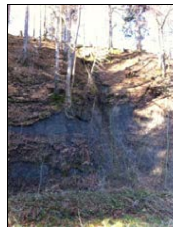
Fig. 12: RG en amont du bassin
