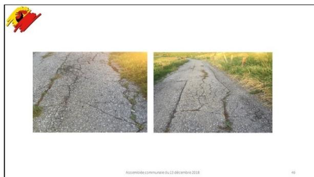
D'une longueur de 270 mètres, le projet comprend une réfection complète du coffre avec une correction du dévers côté amont, puis la pose d'un enrobé bitumeux ACT16. La canalisation a été contrôlée et son remplacement n'est pas jugée nécessaire.
