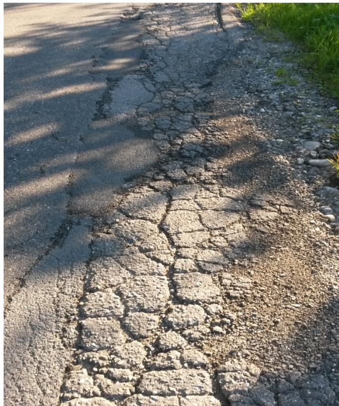
Les travaux prévus seront réalisés avec le même principe utilisé pour les routes AF. Celui-ci consiste en une réfection complète du coffre en le stabilisant au ciment et la pose au-dessus d'un enrobé bitumineux ACT 16.
