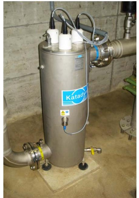
*Les constats effectués lors de l'inspection ont mis en évidence certaines lacunes, en particulier le système de traitement UV non conforme à la directive SSIGE W13.*
